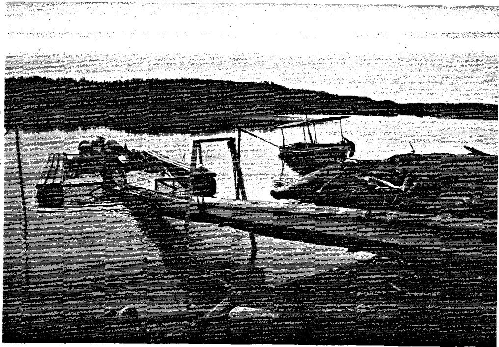
No.13 Les billes sont envoyées sur le convoyeur flottant puis dans le déchetueur.
