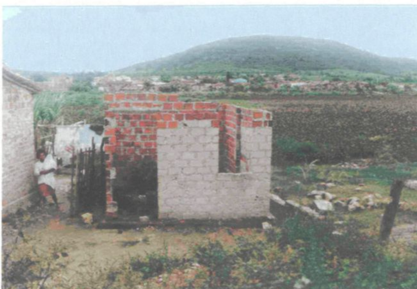
Foto 6: Casa residencial próxima ao açude da Bomba.
