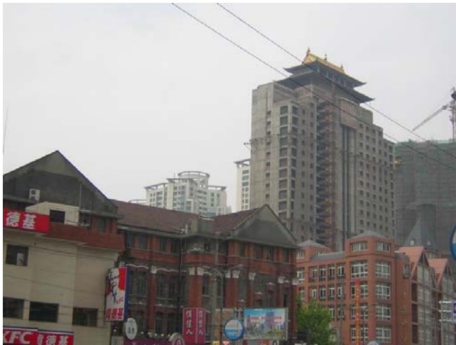
Abb. 75: Ein im Bau stehendes Hochhaus in der Innenstadt Shanghai (Foto: Zhu Miaomiao, April 2004)
