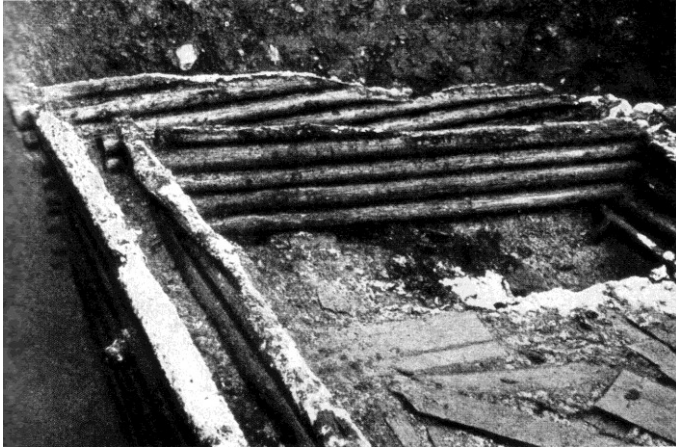
Abbildung 7: 1939 freigelegter Blockbau mit doppelter Wand
