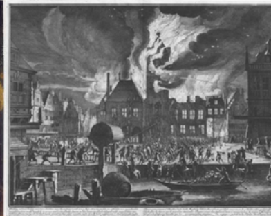
Abb. 4: Jan van der Heyden, Brand des Amsterdamer Rathauses, Figur 3 aus seinem Werk „Beschrijving der nieuwlijks uitgevonden en geotrojoerde Slang-Brand-Spuiten...“, Amsterdam 1690, Stadtarchiv Amsterdam
