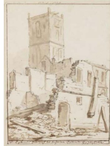
Abb. 147: Anonym, Die Ruine des alten Rathauses , 1652, Zeichnung, Stadtarchiv Amsterdam, Zeichnung Slg. Van Eeghen, Bilddatei-Nr. 010055000350
