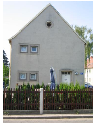
Abb.135: Kopfbau Type A1, mit Eingang für 2 Wohnungen
