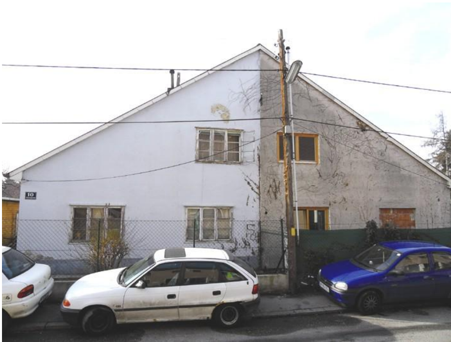
Abb.109 Marangasse (früher Karl Hofmann- Gasse): Doppelhäuser mit stumpfwinkeligem Satteldach (1937) linkes Haus noch original
