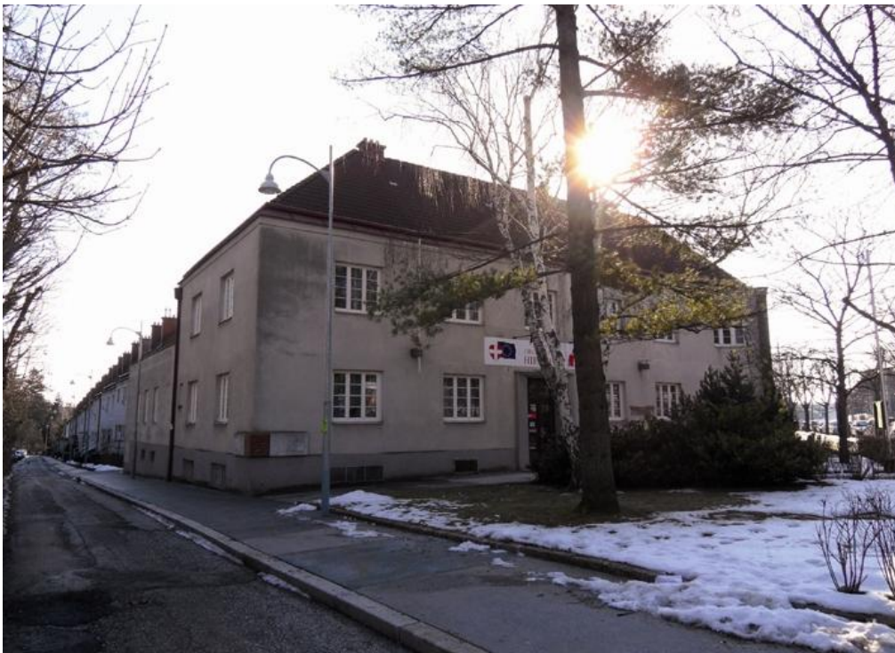
Abb.104 Lockerwiese, Parteiheim, dahinter Festsaal mit Flachdach
