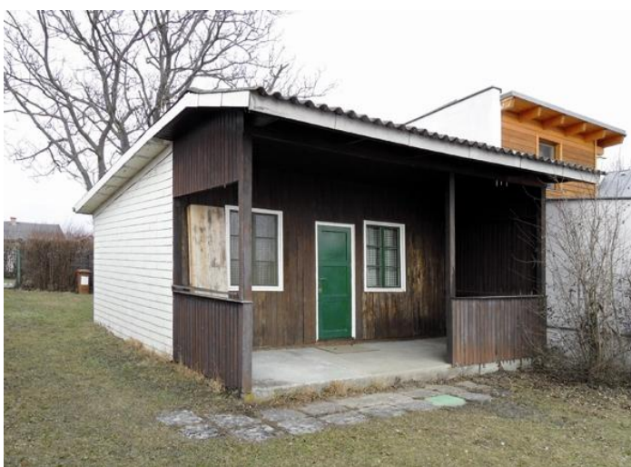
Abb.177: Nachkriegsverwertung eines Spiegel-Behelfsheimes, Veranda-Zubau mit Pultdachabsenkung stammt aus späterer Zeit.
