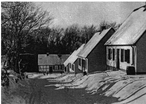
Siedlung Remdelt-Ehringhausen. Bild von Standpunkt 1 bei Lageplans (Seite 17)
