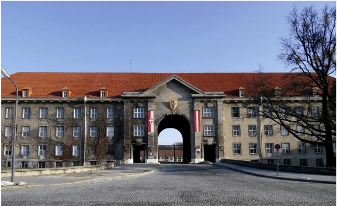
Abb.155: Portal der Fasangartenkaserne
