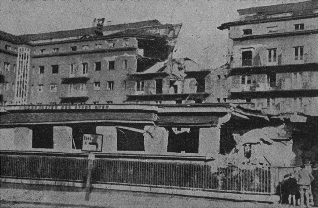
Bombentrichter im Gemeindebau. 32
