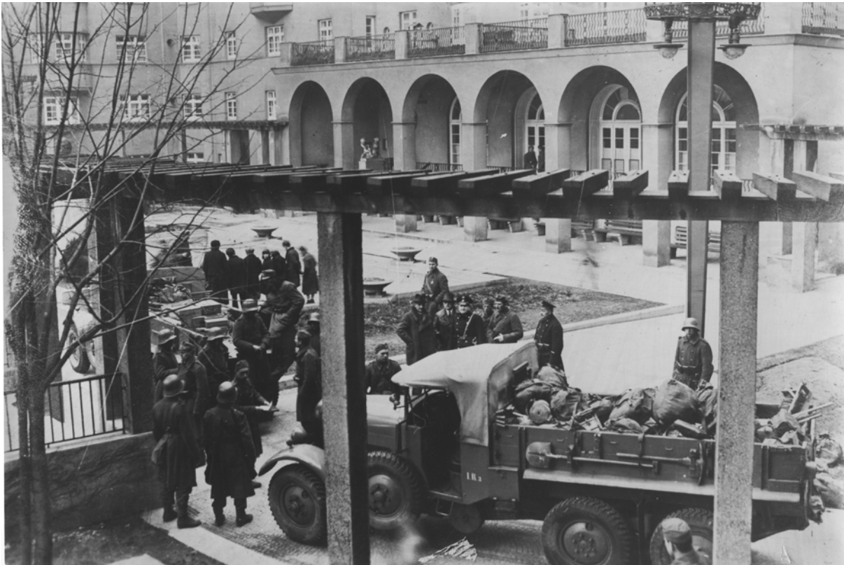
Besetzung des Reumannhofs durch das Bundesheer am 12. Februar 1934 26
