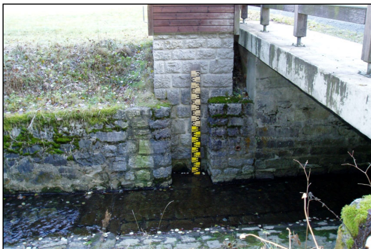
Abb. 13: Lattenpegel an der Messstelle am Langenaubach 52
