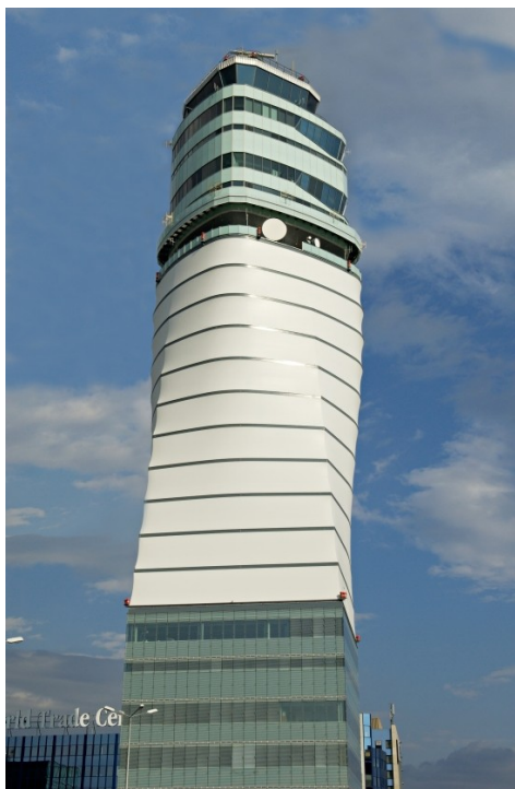
Abbildung 35: Der neue Tower am Flughafen Wien-Schwechat.
