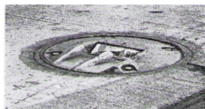
Abbildung 66: Gerichtetes Unterflurfeuer für die Mittellinienbefeuerung.
