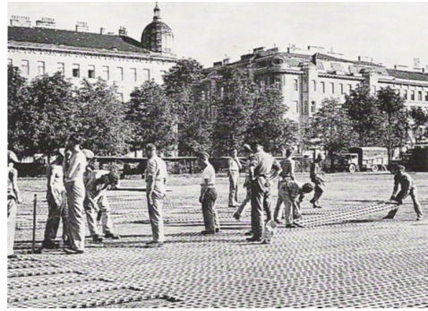
Abbildung 48: Bau des britischen Hilfslandeplatzes vor Schönbrunn.
