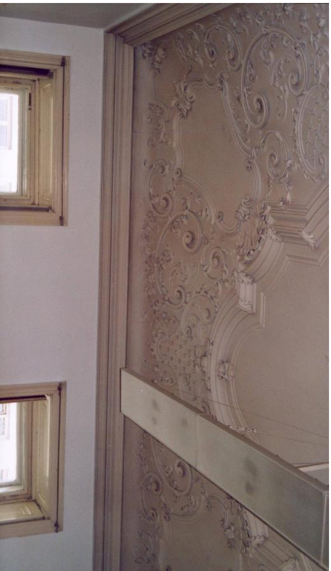
Abb. 183: Palais Corbelli-Schoeller, 2. Stock, 2. Raum straßenseitig. Stuckdecke.
