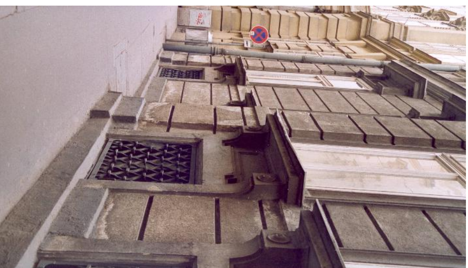
Abb. 29: Fassade, Fensterkonsolen des Erdgeschosses, „Nabelscheiben“.
