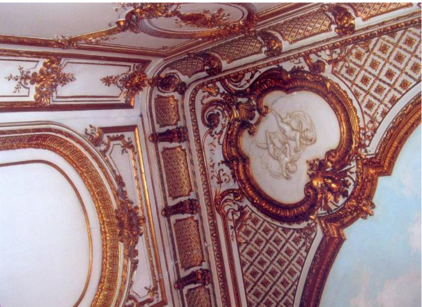
Abb. 91: Palais Corbelli-Schoeller, hofseitiger Salon, Wandaufbau, Hohlkehle Decke.
