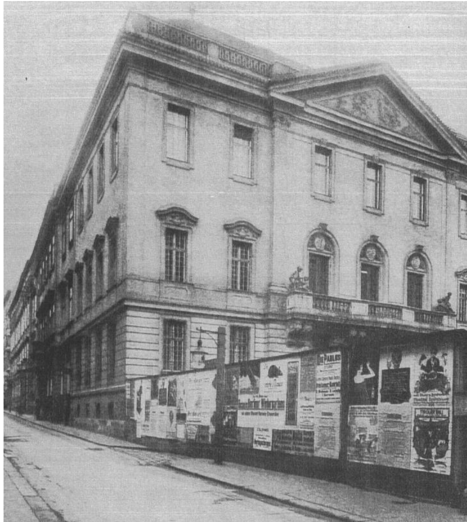
Abb. 11: Zubau an der Ostseite (1909 – 1912).
