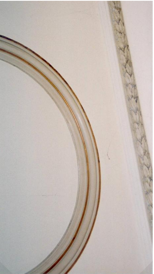
Abb. 145: Palais Corbelli-Schoeller, 1. Stock, Nordtrakt, WC-Raum. Bogen mit Goldfassung.
