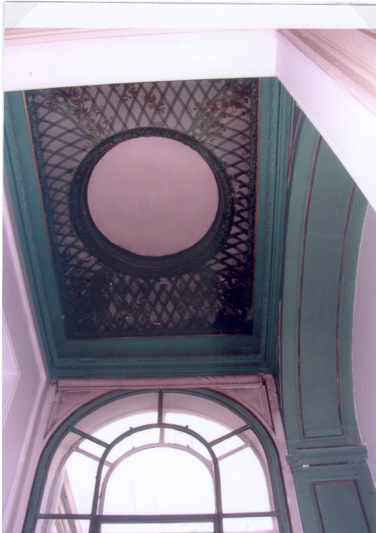
Abb. 142: Palais Corbelli-Schoeller, 1. Stock, Vorraum zum Wintergarten im Norden.
