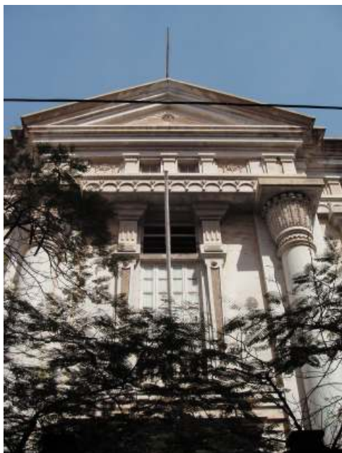
Detalle de la fachada con el Ojo de Dios. Logia Añaza. Santa Cruz de Tenerife. Manuel de Cámara, 1900-1922.
