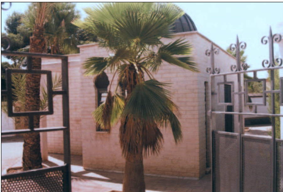
Espacio construido en el interior del cementerio musulmán de la ciudad de Murcia, donde además de la sala destinada al lavado de cadáveres hay un pequeño oratorio.
