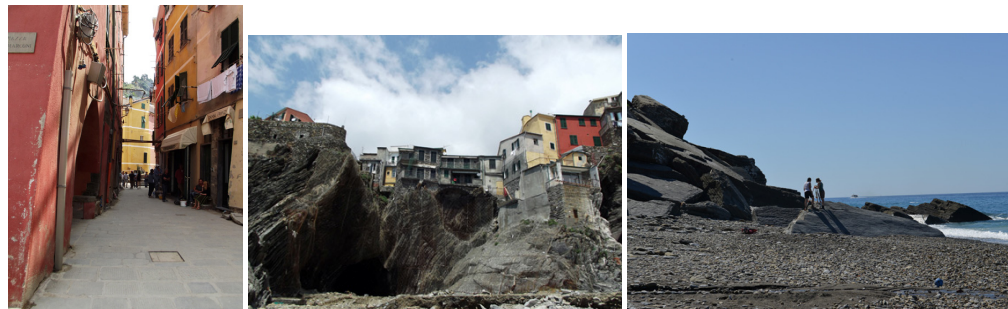
Figura 3. Scorci della via principale del borgo e della spiaggia formata dall'accumulo dei detriti alla foce del Vernazzola, anch'essi oggetto del rilievo laser scanning (foto P. Maschio).
