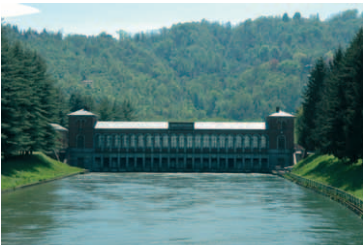
L'imponente opera della presa del Canale Cavour a Chivasso dove è stato promosso nel PISL del parco l'Ecomuseo omonimo.
