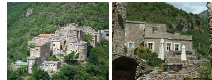
[Figg. 41-42 - 1991/1998 - Colletta di Castelbianco, Castelbianco, valle Pennavaira (SV), 300 m s.l.m. Ristrutturazione e rifunzionalizzazione dell'intero borgo ad opera di un'unica società. Progettista: Giancarlo de Carlo. Elementi caratterizzanti:
