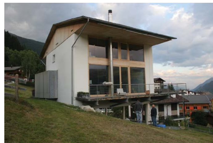
[Fig. 4 - arch. Werner Schmidt, Haus Braun, Disentis, Grigioni realizzata con le pareti perimetrali in paglia - foto Andrea Bocco]
