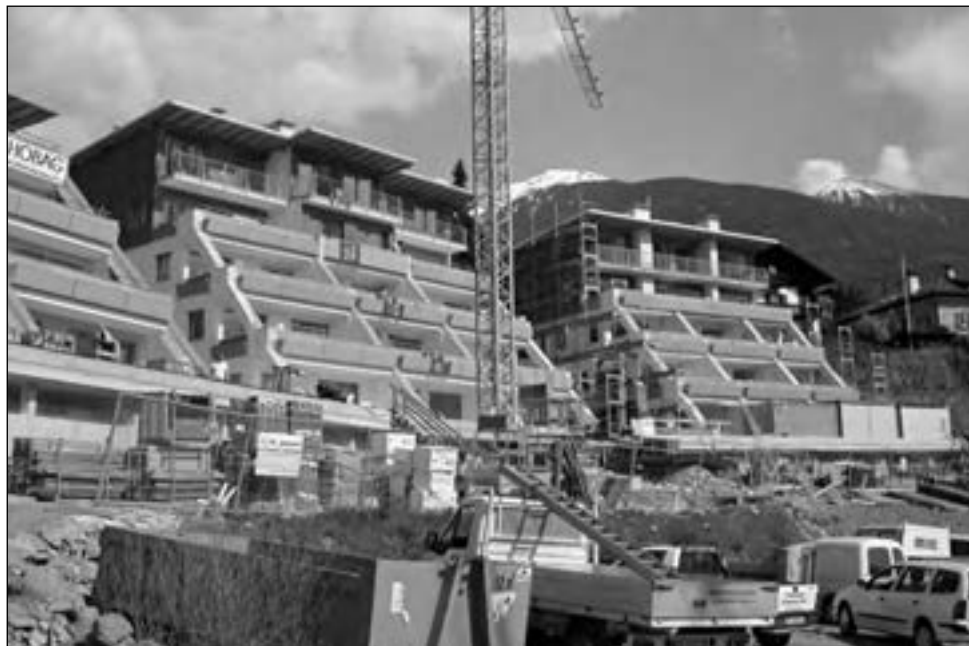
Cantiere di edilizia residenziale bioclimatica a Bressanone
