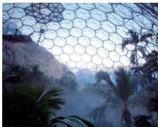
Fig. 2-14 L'Eden Project, il mondo in una serra. E' ricostruita la vegetazione di diversi biomi con finalità didattiche (progetto architettonico di Nicolas Grimshaw & Partners, 1998-2001).
