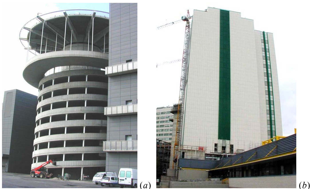
Figura 4.3. Strutture oggetto di caratterizzazione dinamica: (a) Eliporto nel quartiere fieristico a Bologna; (b) Torre di sicurezza dell'Ospedale Maggiore a Bologna.
