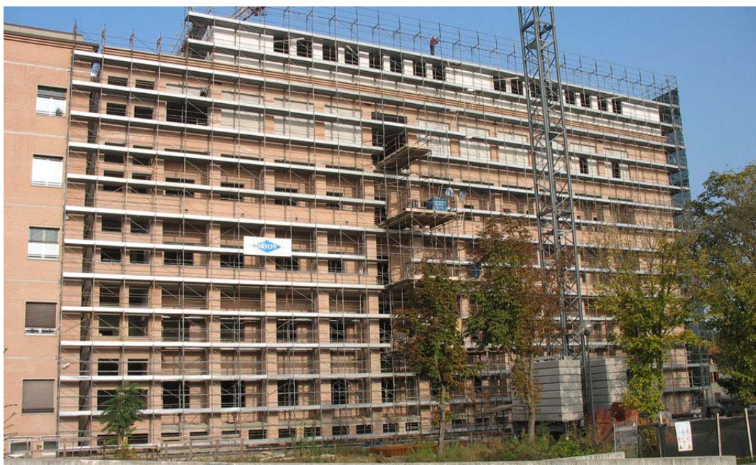
Figura 4.5. Vista complessiva della nuova ala Nord dell'Ospedale S.M. Nuova in Reggio Emilia.
