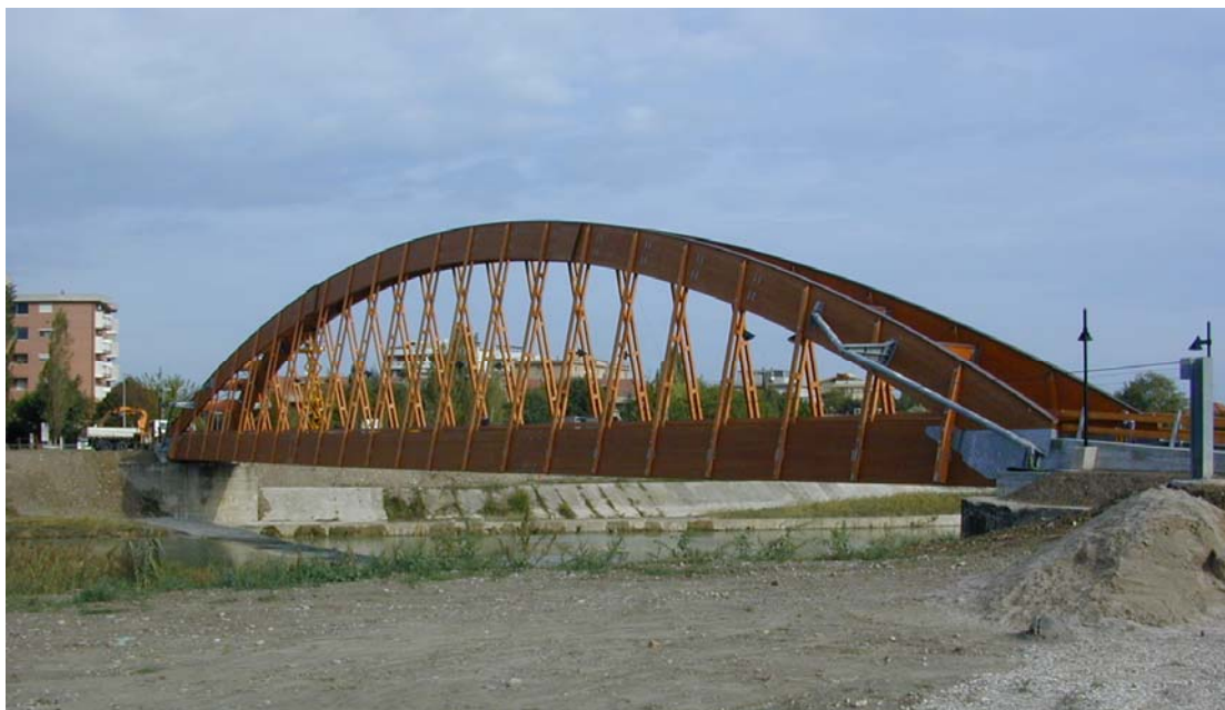
Figura 5.12. Vista della passerella pedonale sul fiume Marecchia.
