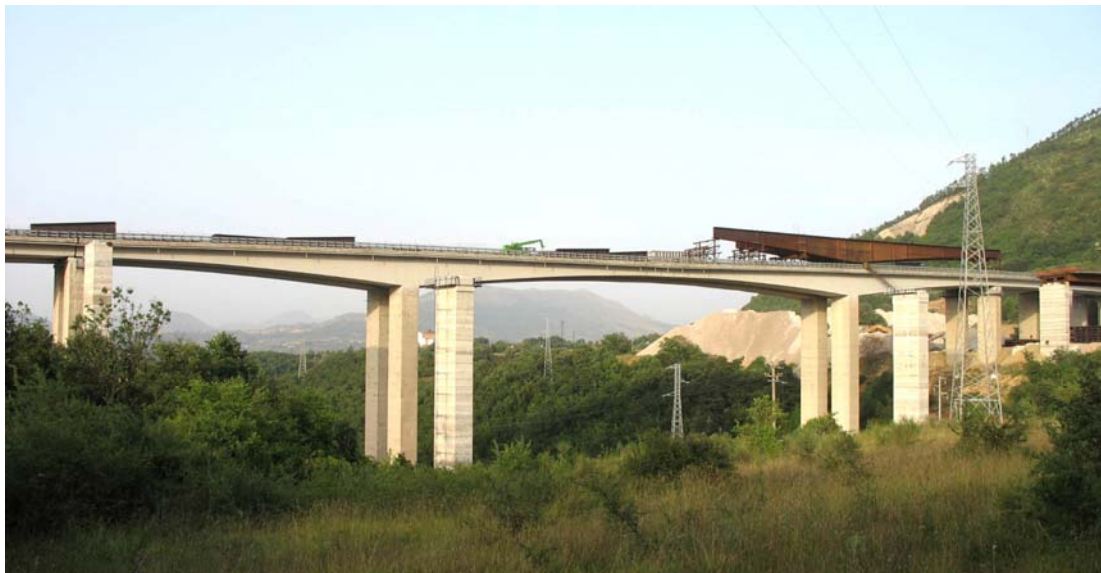
Figura 5.1. Viadotto Incoronata sull'Autostrada Salerno-Reggio Calabria.
