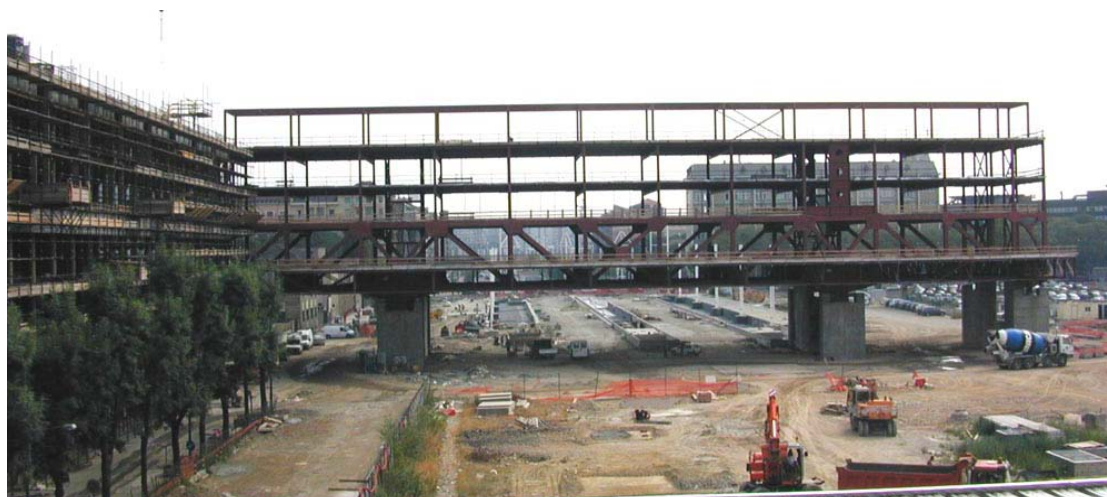
Figura 4.13. Prospetto della struttura oggetto di prove di identificazione dinamica con vibrodina.
