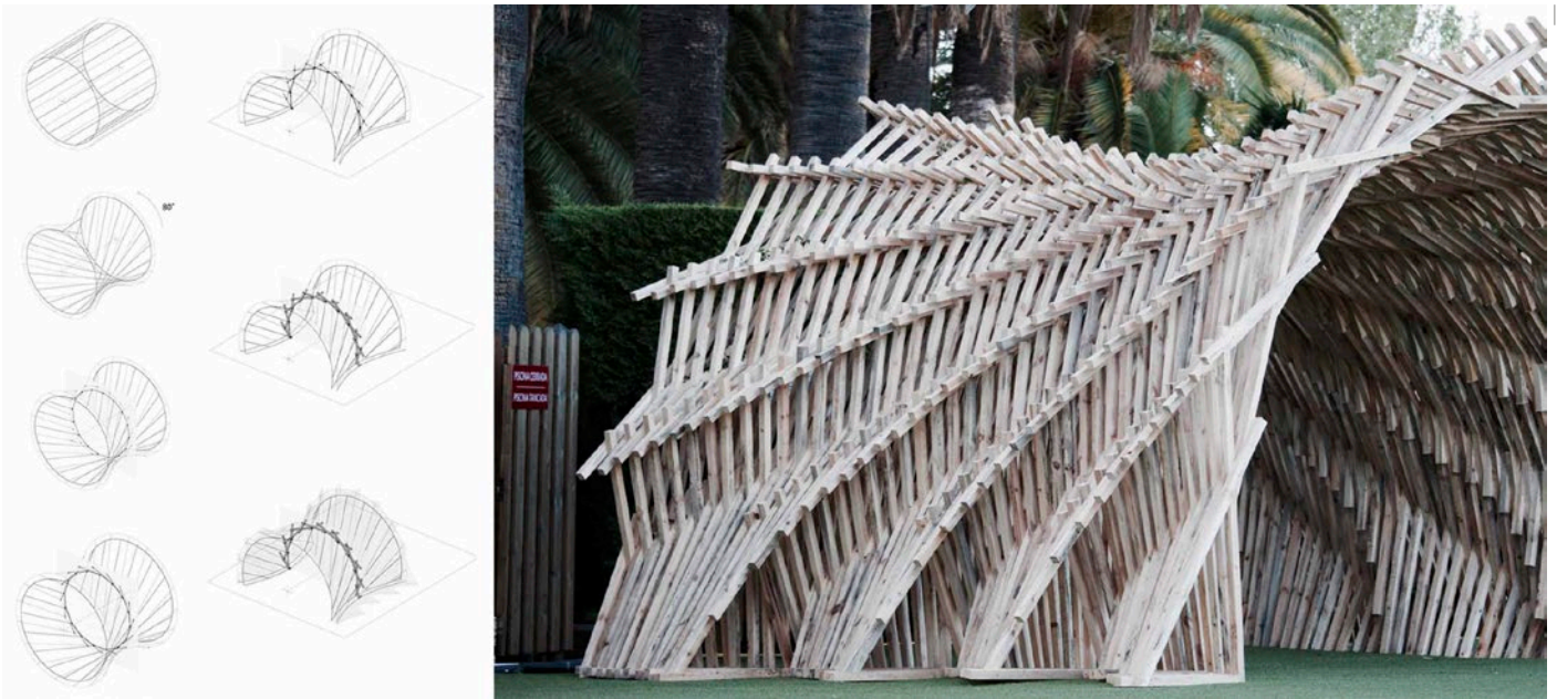
03 | Padiglione Fusta Ròbotica installato alla Setmana de la Fusta di Barcellona, e processo di sviluppo formale dell'iperboloide, in cui la rotazione di elementi geometrici continui ha generato la configurazione spaziale dinamica, elaborazione di Angelo Figliola.
