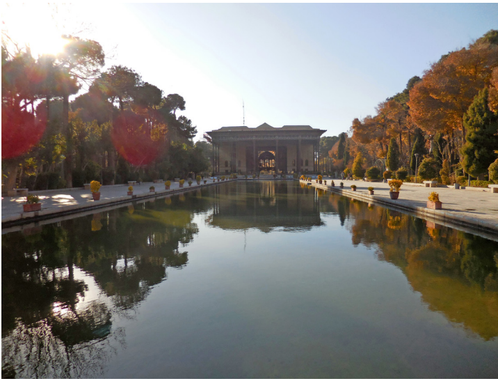
Fig. 2. Palazzo Chehel Souton (delle Quaranta Colonne) a Isfahan, in Iran; l'edificio, realizzato nel XVII secolo dallo Scià Abbas II, è stato restaurato da Eugenio Galdieri nel 1974. Questi seguì le opere di rinforzo della struttura e, in particolare, del colonnato ligneo (foto D. Fiorani 2016).
