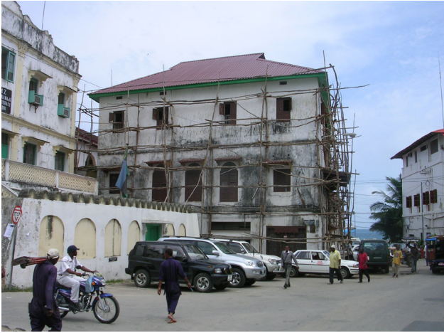
Fig. 6. Ponteggi locali nell'edilizia storica di Stone Town, città capoluogo dell'isola di Zanzibar, in Tanzania (foto D. Fiorani 2007).
