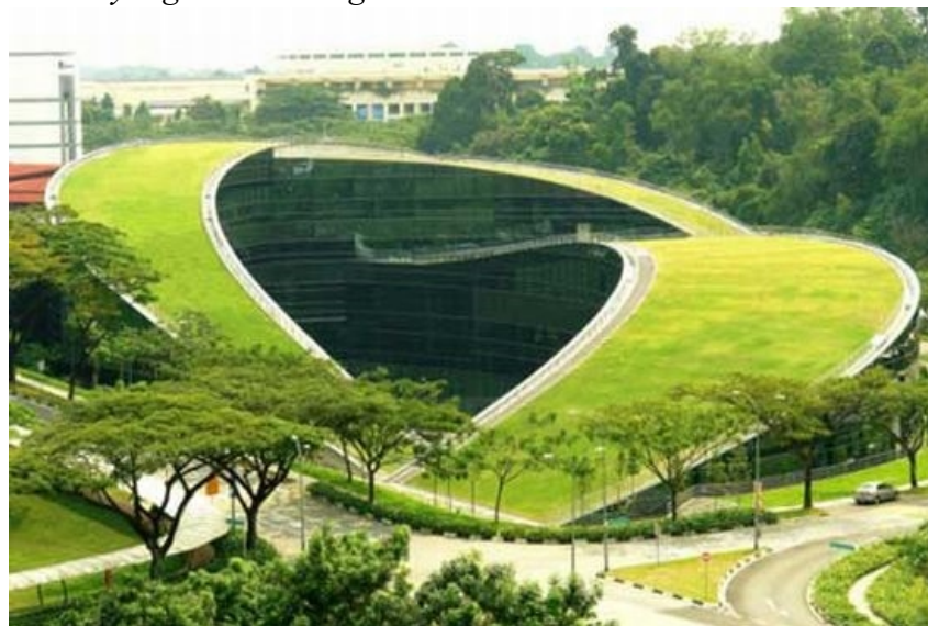
Gambar 10. Teknologi bumbung hijau di The Nanyang Technological University of Singapore (Bari 2011)
