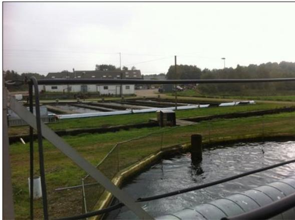
Abb. 2b: Intensive Forellenteich/-tankanlage in Dänemark, bei der das Wasser zwischen den Kompartimenten gepumpt wird (Quelle: [www.undercurrentnews.com](http://www.undercurrentnews.com)).
