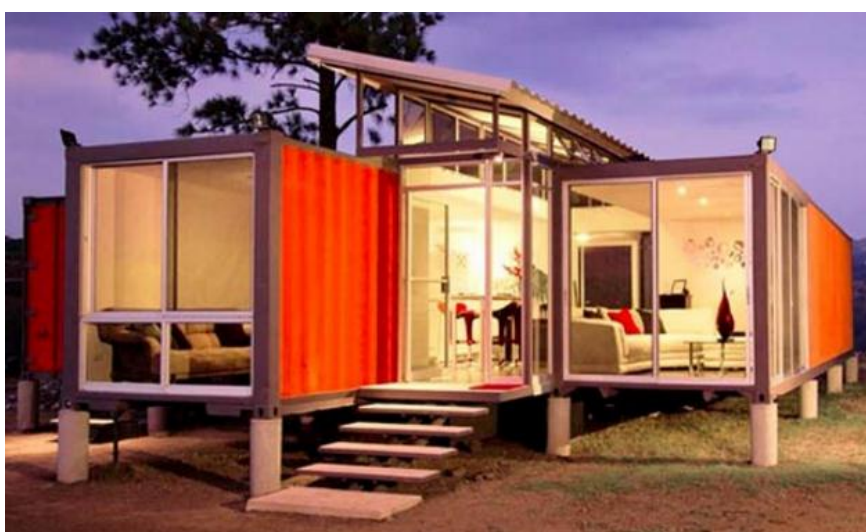
Figura 10 – Casa contêiner na Costa Rica
