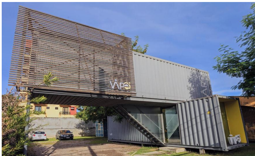
Figura 13 – Escritório em contêiner em Manaus
