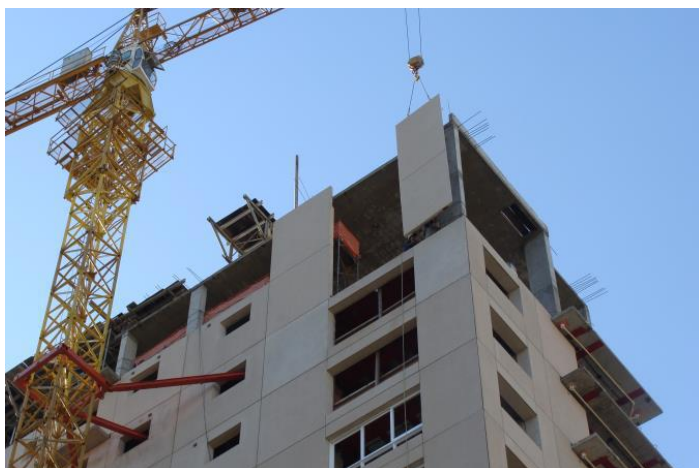
Figura 15 - Equipamento de içamento
