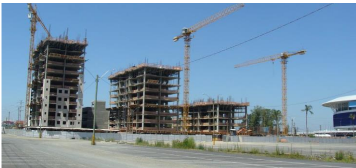
Figura 9 – Edifício Liberdade I - OAS, Porto Alegre/RS
