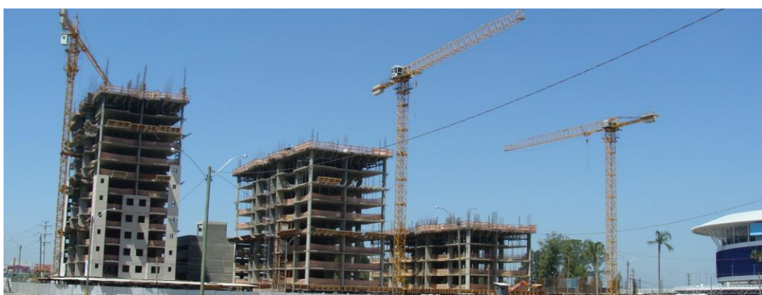
Figura 4 - Edifício Liberdade I - OAS - Porto Alegre/RS.
