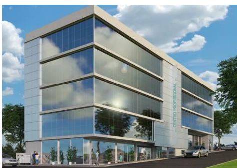
Figura 16 - Fachada do edifício
