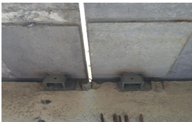
Figura 13 - Fixação dos painéis
