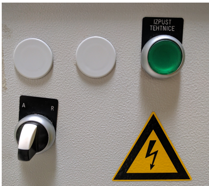
Slika 2.7: Stikalo in tipka za ročno krmiljenje spustne lopute, vrtiljaka in tiskalnika.
