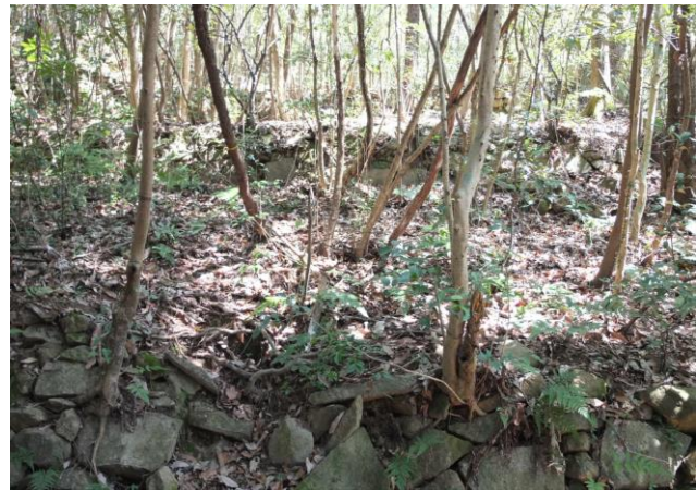
写真7 段々畑であったと推測される。画面の横は 2m で石垣の高さは 70 cm 程度。
