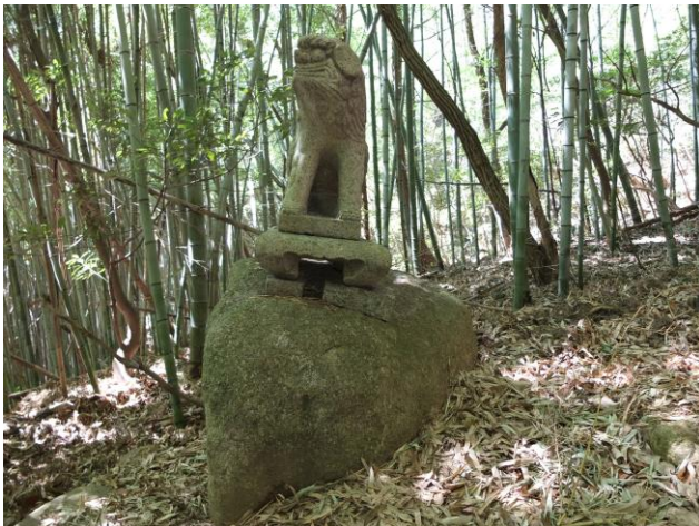
写真16 狛犬の台座が傾いている。この斜面が動いている可能性がある。
