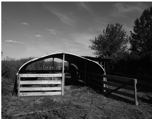
Figura 2. Sistema de instalaciones para producción porcina familiar. Alternativa cría y recria
