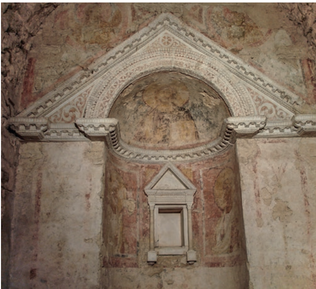
Abb. 7: Tempietto del Clitunno bei Spoleto (I). Blick ins Innere mit Konsolen entlang dem Gebälk und blockförmigen Konsolen als Stützen der Schrein-Säulchen (a). Rom (I), Casa dei Cavalieri di Rodi. Wand mit einer Serie von kleinen Konsolen, aus den Grabungen in der Kirche des Hl. Basilus im Forum Romanum (b).
