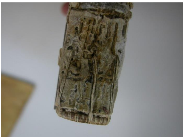
Part inferior del lloc, un cop desmuntada, afectada per xilòfags.
