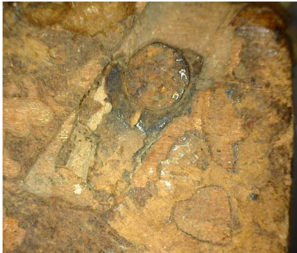
Restes dels anclatges de les trencafiles a les tapes amb un gavarrot
