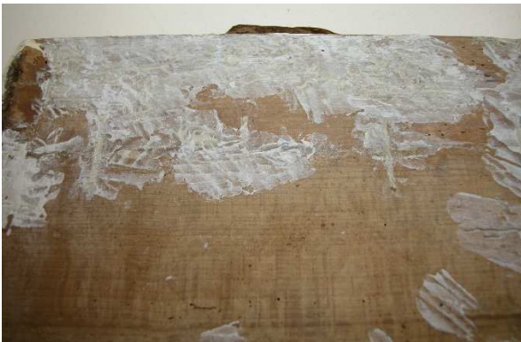
Imatges de la reintegració de galeries de corcs
