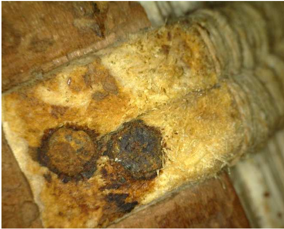
Ancoratge de nervis a la tapa fusta
