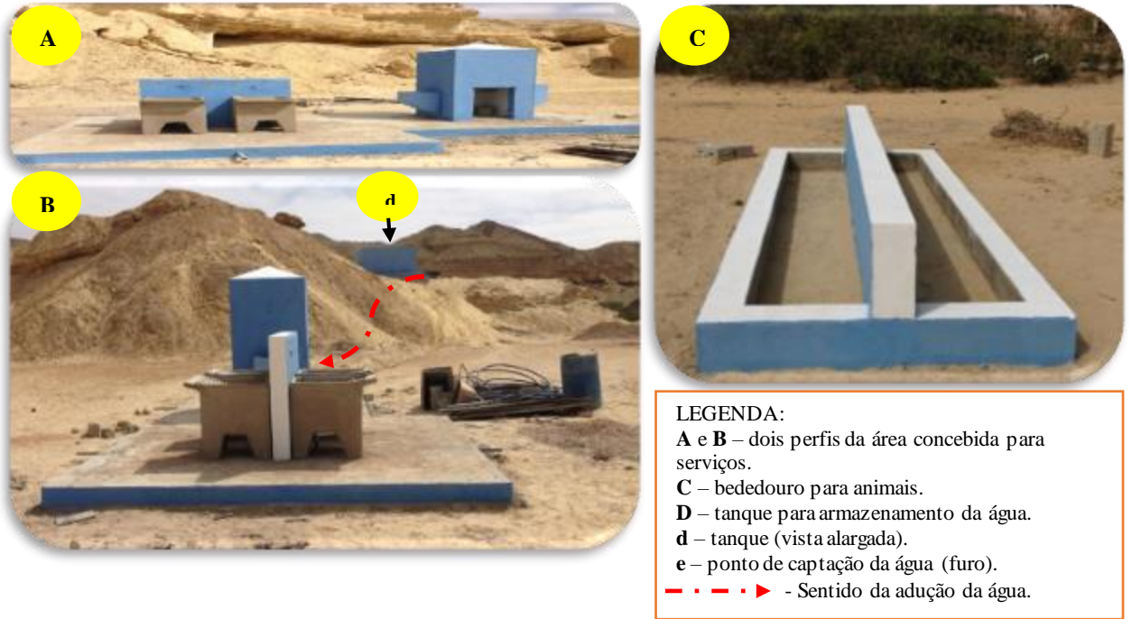
Anexo 5: Infraestruturas para captação e armazenamento de água implantadas na localidade de Arcos em Outubro de 2014 (Imagens de Janeiro de 2015).
