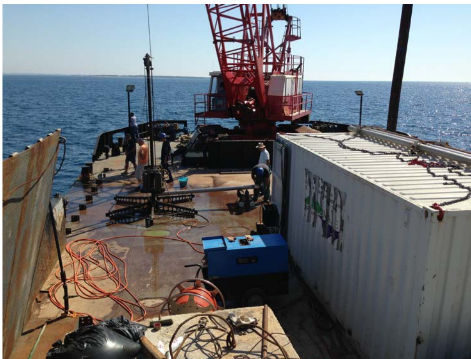
Foto 1 – Allestimento cantiere con Vibro carotiere Geo-core 3000 e laboratorio mobile.
