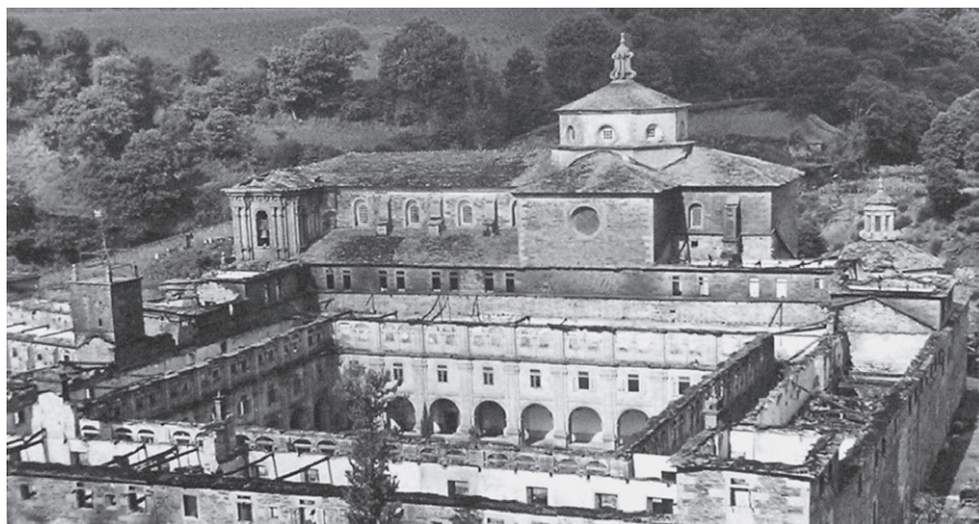
Fig. 19. Detalle del estado de las cubiertas de la iglesia, la sacristía y el signo, parcialmente dañadas por el fuego. Fondo fotográfico del monasterio de Samos.
