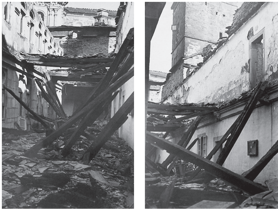
Figs. 15 y 16. Estado del interior de las galerías de los dos pisos superiores del ala noreste del claustro de las Nereidas tras el incendio. Fondo fotográfico del monasterio de Samos.
