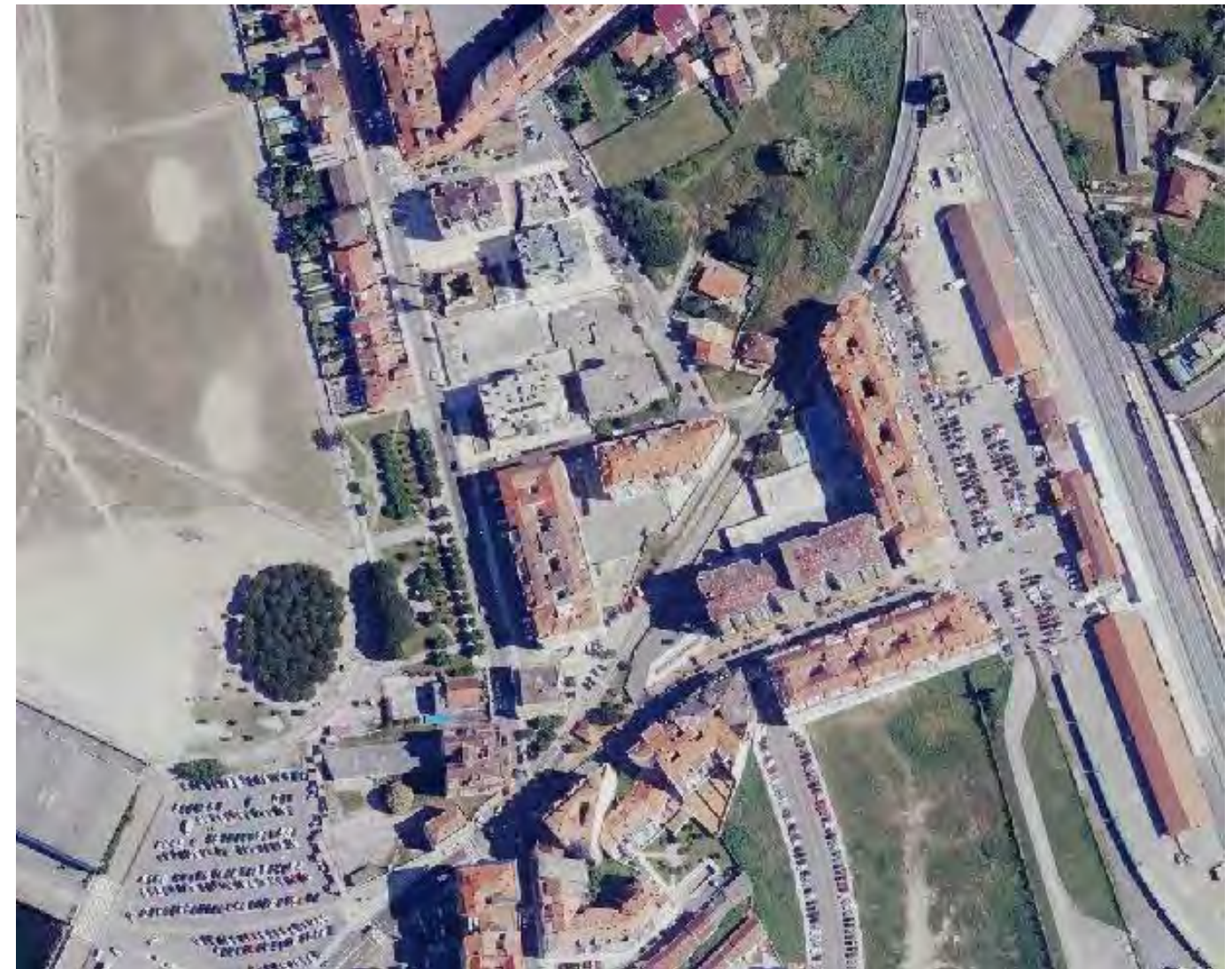
Imagen.3 Estación de Ferrocarril
