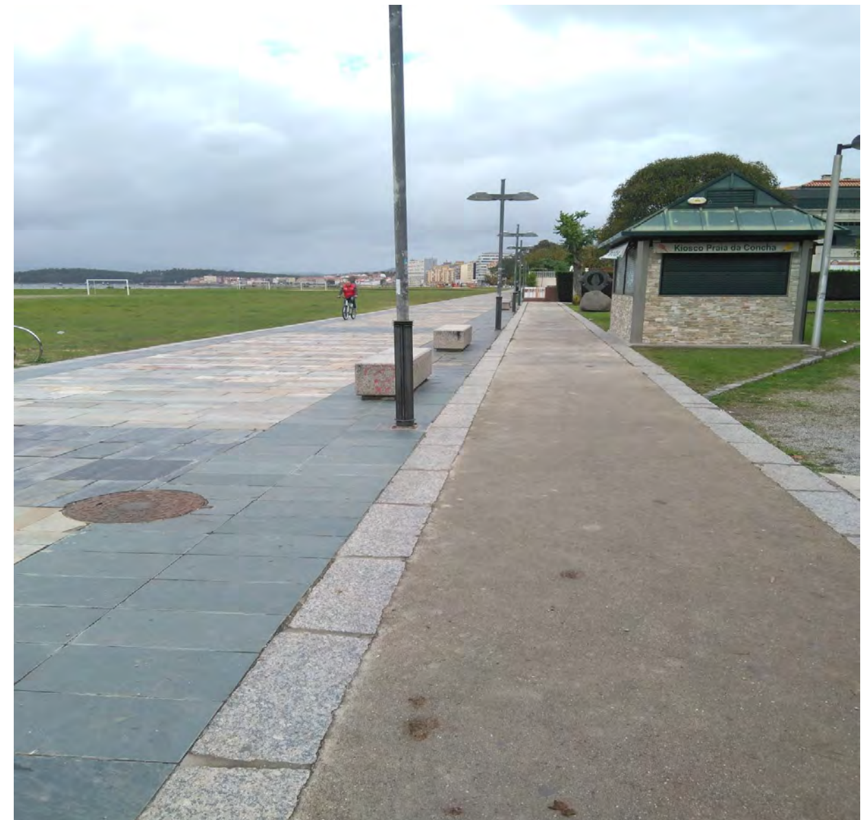
Imagen.3 Tramo de acera-bici sin funcionalidad
