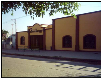
Foto 2 Edificio escolar Caso EPriv02
