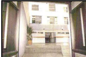
Foto 4 Edificio escolar Caso EPriv04
