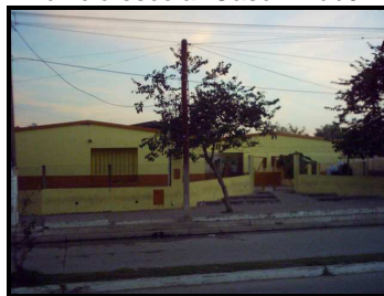
Foto 1 Edificio escolar Caso EPub01
