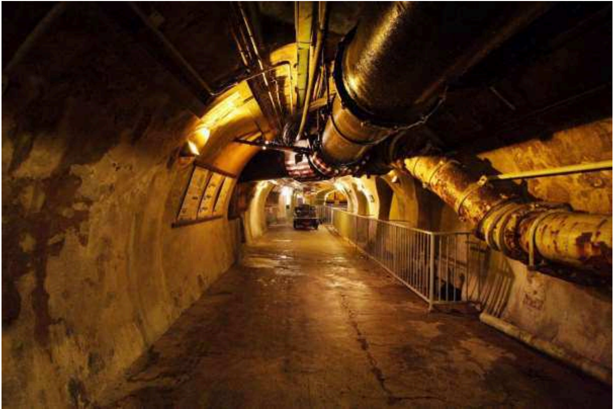
Figura 14- Museu do Esgoto - Paris, França
