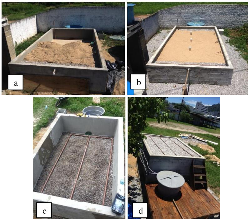
**Figura 12 - Preenchimento com material filtrante e disposição das tubulações de distribuição e coleta de esgoto nos WC.**
