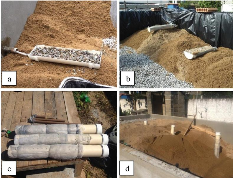
**Figura 13 – Implantação de amostradores em pontos intermediários nas unidades WCVD e WCH.**
