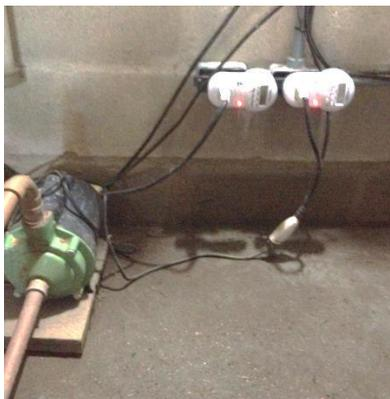
**Figura 21 - Conjunto bomba-timer responsável pela aplicação de esgoto no sistema híbrido.**
