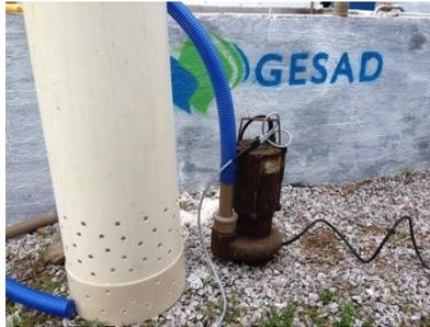
**Figura 20 - Bomba da estação elevatória de esgoto bruto e tubo camisa.**
