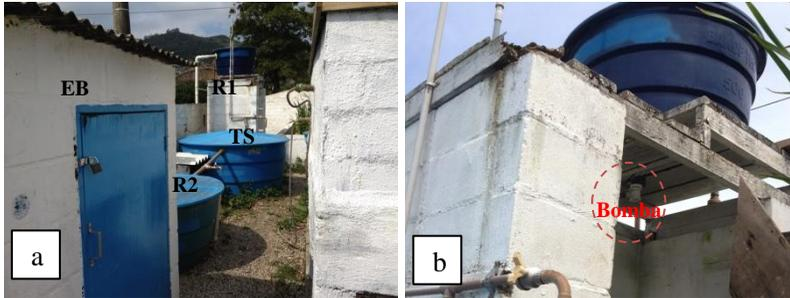
**Figura 15 - Reservatório Elevado (R1), Tanque Séptico (TS), Poço Úmido (R2) e Estação de Bombas (EB).**
