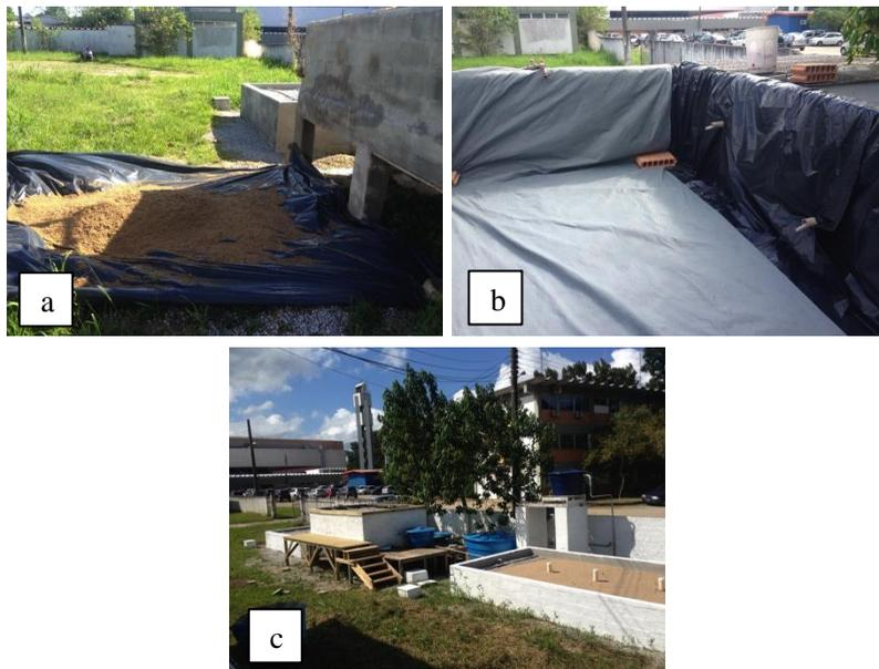
**Figura 17 - Teste de estanqueidade e troca do material filtrante do WCVD.**
