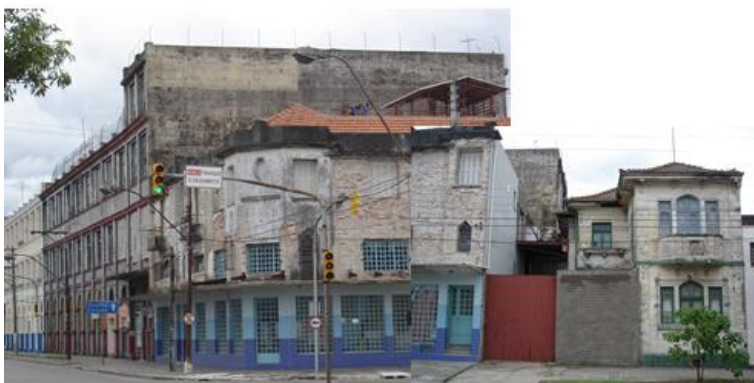
Figura 3: traçado urbano do IV distrito, edifícios industriais, comerciais e residenciais na mesma quadra.
