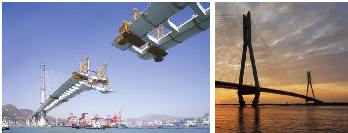
Figura 3.19 – Tabuleiro metálico – Ponte Stonecutters
