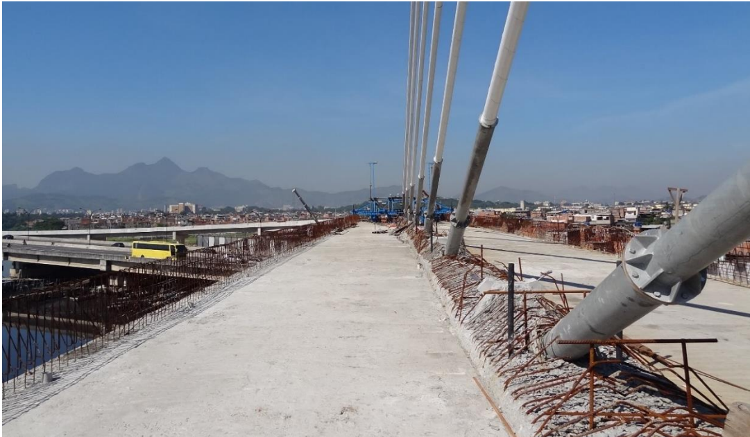
Figura 3.33 – Tabuleiro na fase construtiva
