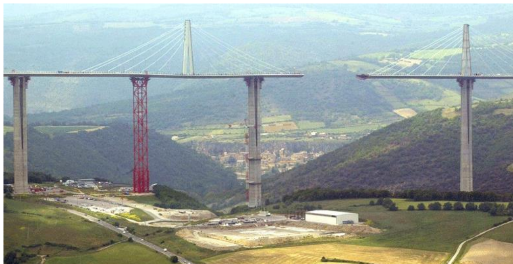
Figura 3.25 – Exemplo de construção por incrementos modulados – Viaduc de Millau – vista frontal
