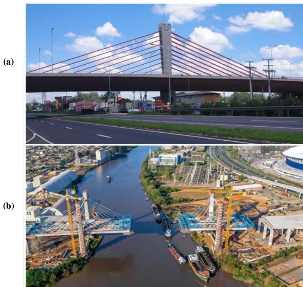
Figura 1.1 – (a) viaduto estaiado sobre a BR-116 e (b) ponte estaiada sobre o rio Gravataí
