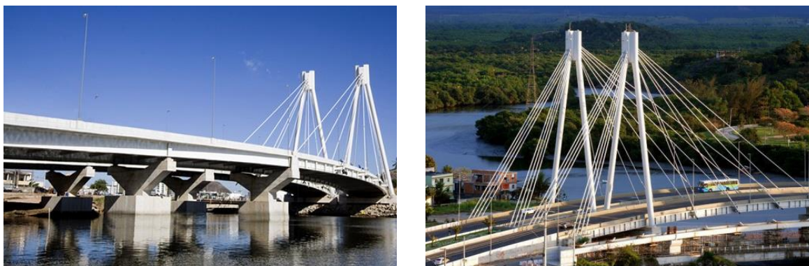
Figura 3.20 – Ponte estaiada com laje mista – Ponte da Passagem
