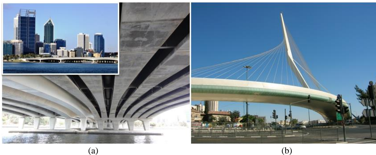
Figura 2.3 – Exemplo de ponte com estrutura (a) em concreto protendido e (b) estaiada
