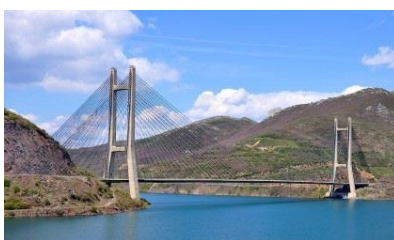
Figura 3.14 – Exemplo de distribuição transversal dos cabos (a) Sunshine Skyway Bridge , (b) Ponte Barrios de Luna, (c) Tatara Bridge
