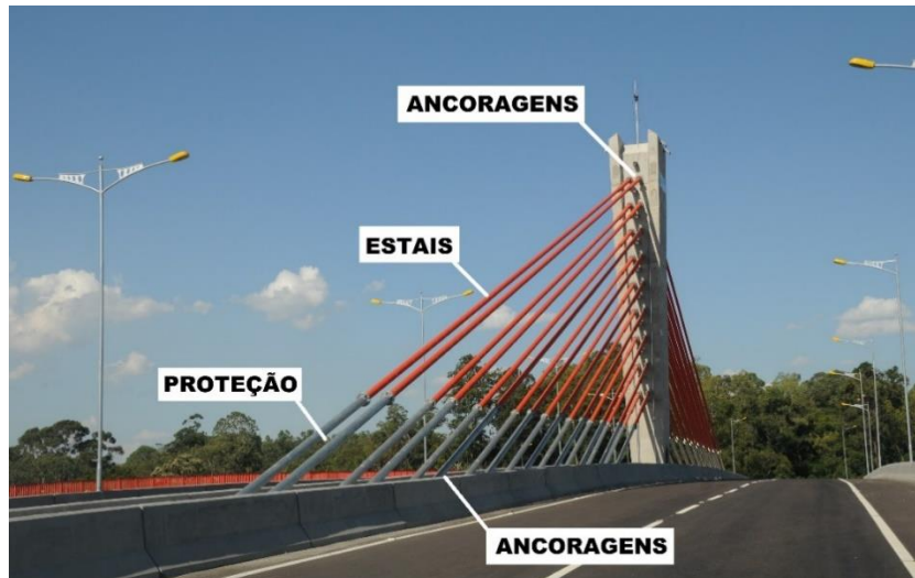
Figura 3.10 – Representação dos componentes dos estais
