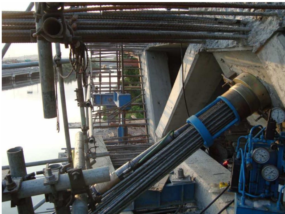
Figura 3.31 – Detalhe da protensão dos estais
