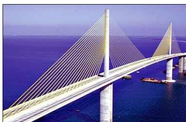
Figura 3.14 – Exemplo de distribuição transversal dos cabos (a) Sunshine Skyway Bridge , (b) Ponte Barrios de Luna, (c) Tatara Bridge
