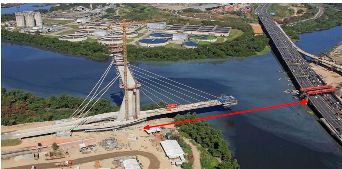
Figura 3.37 – Construção por balanços sucessivos
