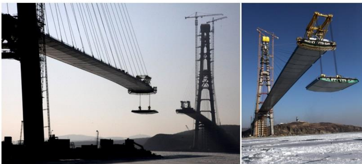
Figura 3.26 – Exemplo de construção por balanços sucessivos na construção da Rusky Island Bridge na Rússia
