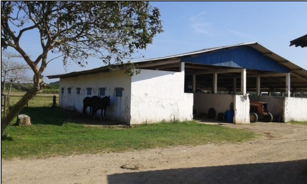
Figura 19. Visualização da infraestrutura da Fazenda Cordeiros, destinada a comercialização de equinos e bovinos.
