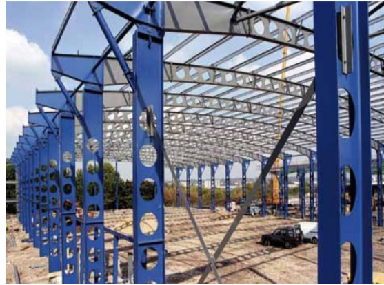
Fig.1.4.- Pòrtic d'elements corbs i perforats.
