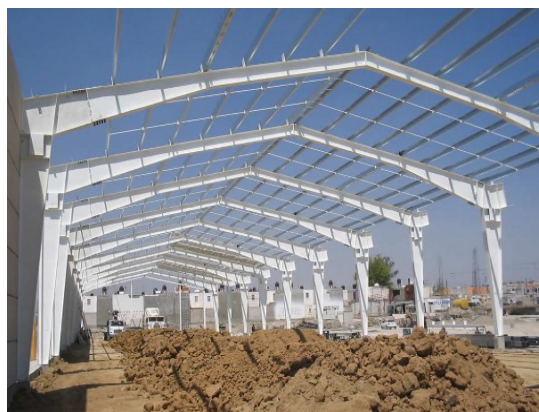
Fig.1.2.- Pòrtic a dues aigües de secció variable.
