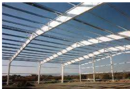
Fig: 2.-Exemple de pòrtics amb perfils d'ànima plena
