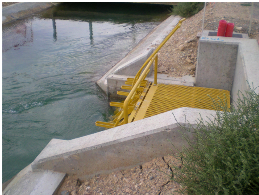
Fig. 31. Captación de la Acequia de Terreu
