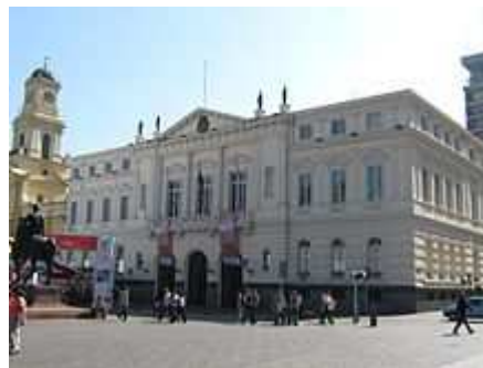
Fig 2. Edificio de la Ilustre Municipalidad de Santiago. Aunque originalmente era la encargada de la administración de toda la ciudad, desde 1891 sus competencias se limitaron al casco antiguo de la ciudad debido a la creación de nuevas entidades territoriales.
