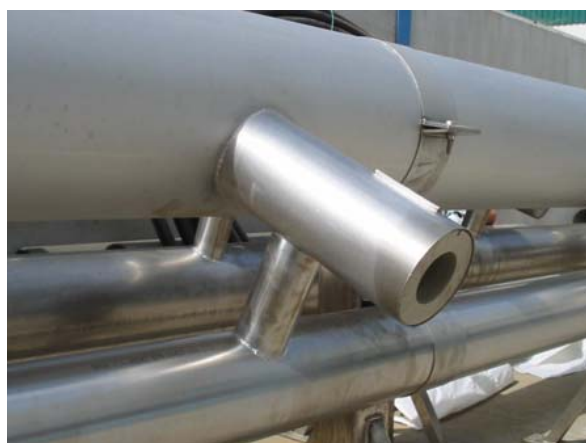
Detalle de un inyector
