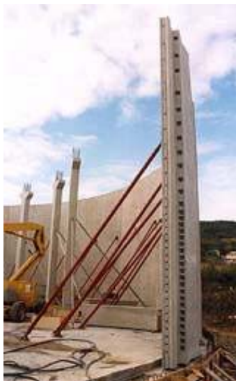
Depósito de hormigón prefabricado en construcción
