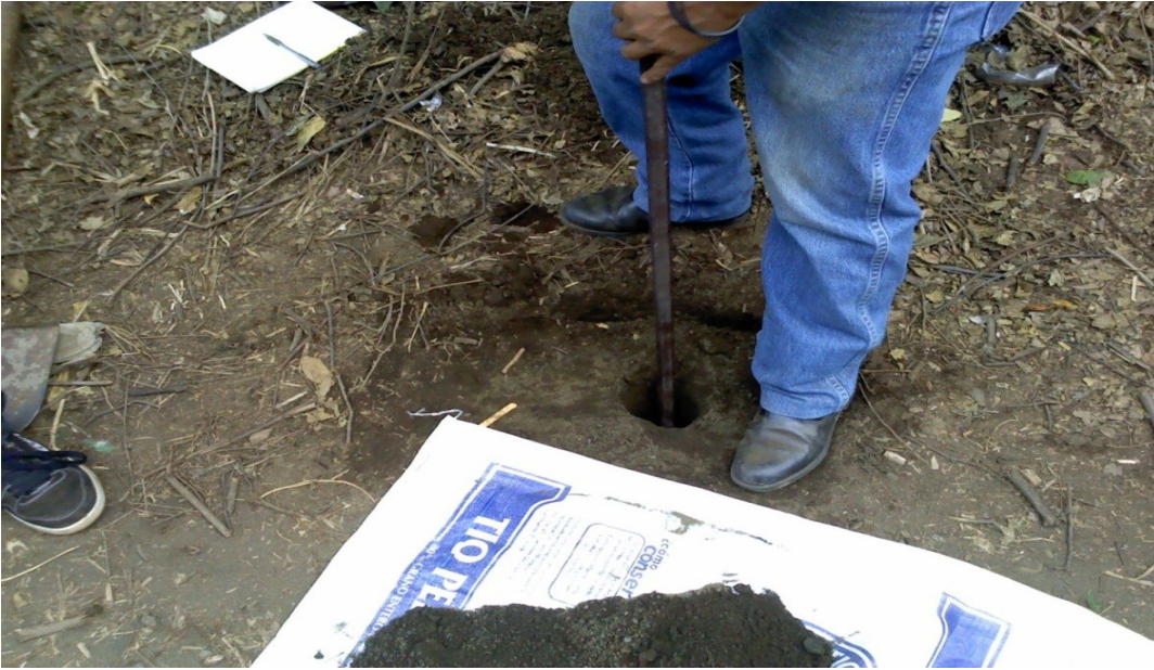
Foto A-II.2.1 -Sondeos manuales realizados para la extracción de muestras del sub suelo de tramo de camino Ticuantepe-Manuel Landez.
