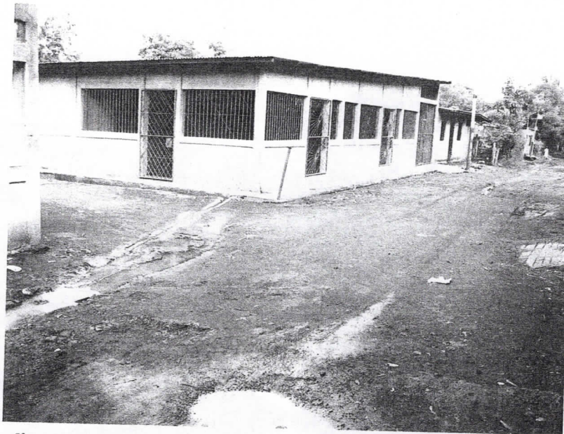
En esta fotografía se puede apreciar lo deplorable del estado de las avenidas del barrio en estudio.
