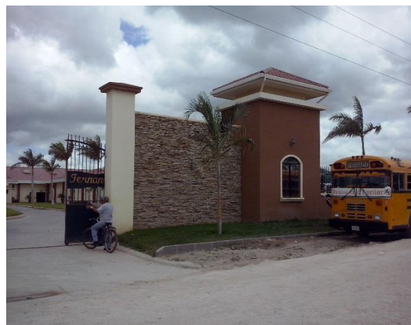
Foto 6: Caseta de seguridad.
