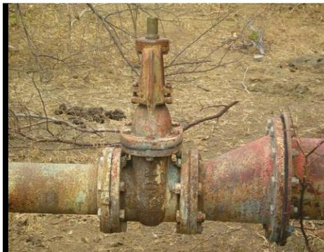
Fig. 1.6 y Fig. 1.7 Estado de la sarta de salida del Tanque existente, propiedad de INTUR. La línea de conducción que sale del tanque de almacenamiento, está conformada por tubería PVC de 6” de diámetro, la que se extiende en una longitud aproximada a 4,000 metros.
