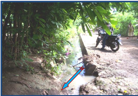
Foto N°8: sedimentación al inicio del canal Barrió Oronte Centeno Fuente: Elaboración propia julio 2012
