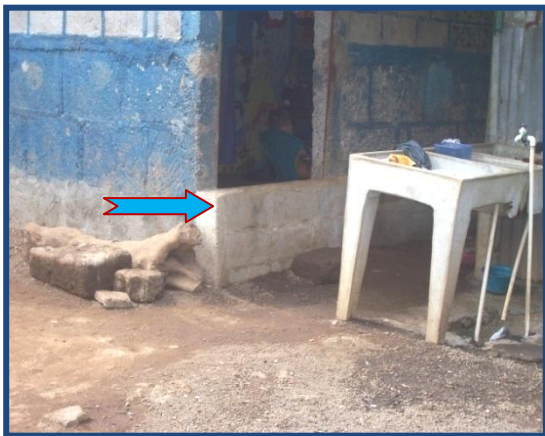
Foto N° 3: Construcción de pared para evitar la Acceso de aguas a las casas, Barrio Ana Virginia Fuente: Elaboración propia julio 2012
